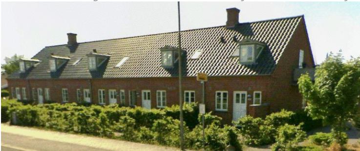
Figur 3: Facade mod nord mod Strandvejen
